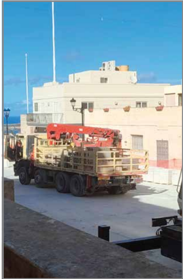
Il-bricks għall-bini tal-kolonni.
