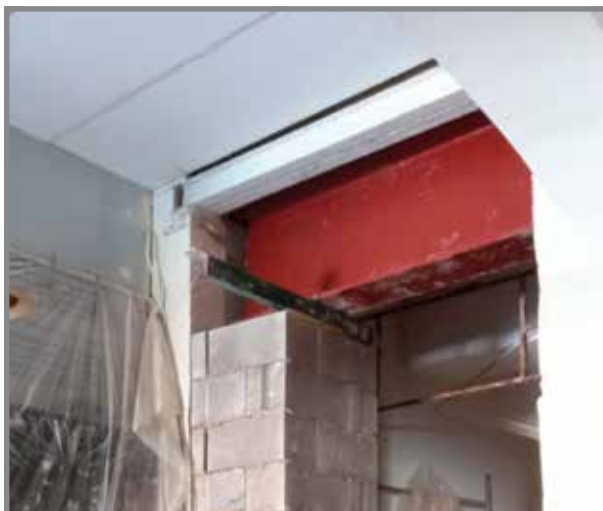
Wieħed mit-travi f'postu fuq il-kolnani.
